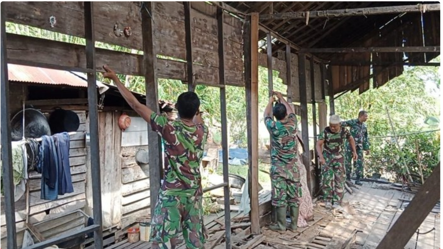
Hari ke Dua Bantuan Rehab RTLH Kodim 1006/Bjr, Bangun Tiang dan Rangka Rumah
